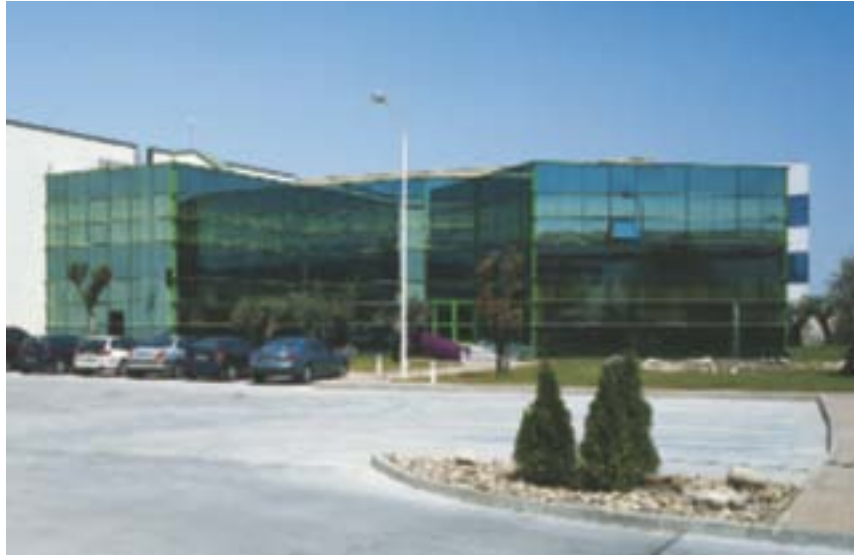
Instalaciones en Alcalá de Henares (Madrid), inauguradas en el año 2003.
